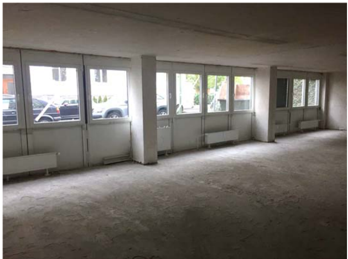
Zurückgebaute Büroflächen im Erdgeschoss
